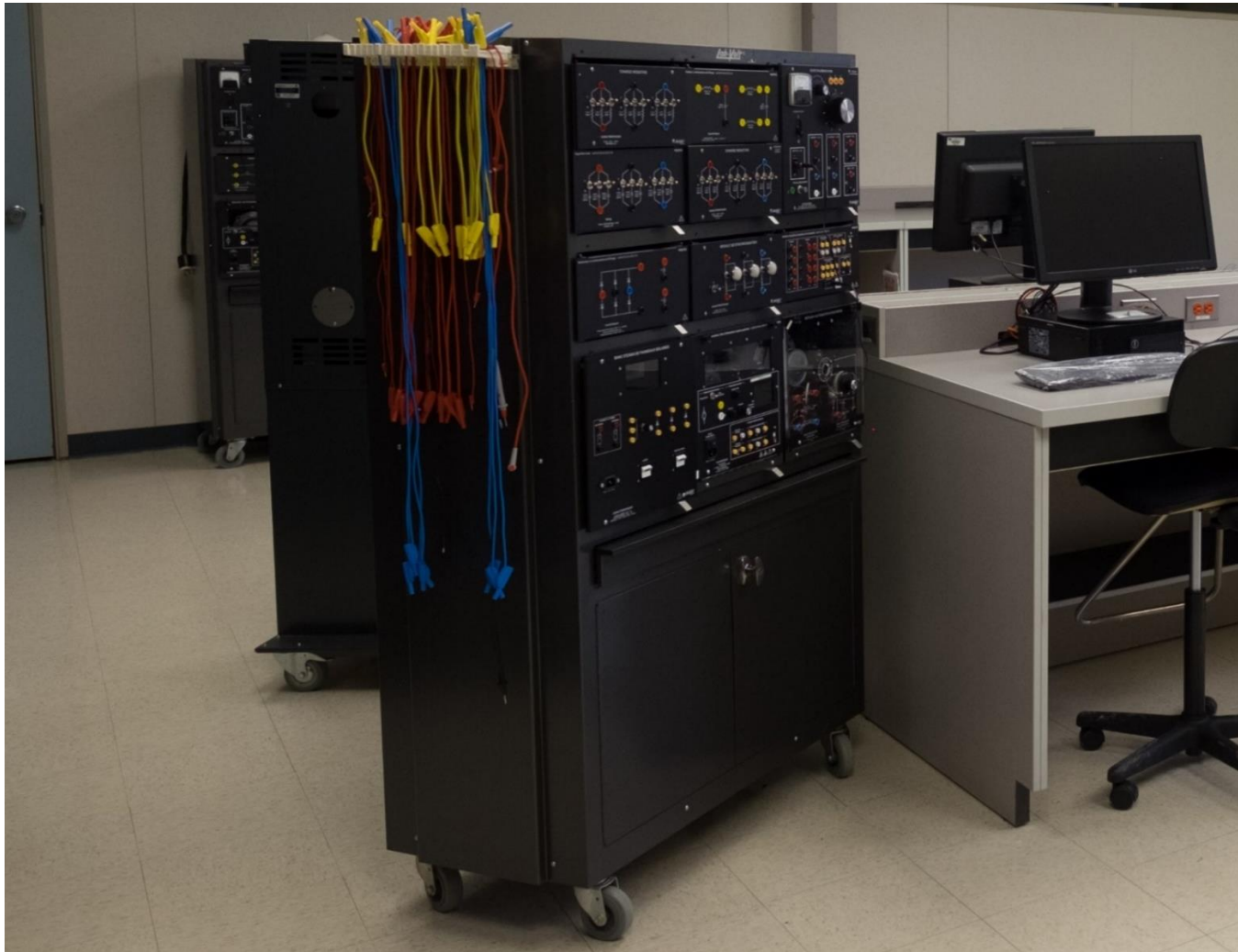
Figure 1 : Poste de travail Festo (LabVolt) Électrotechnique
