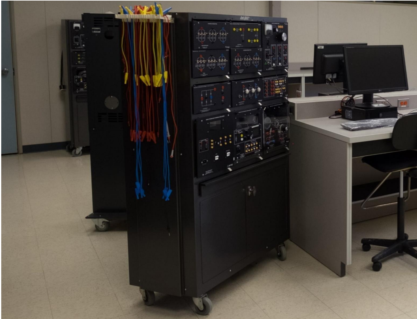
Figure 1 : Poste de travail - Électrotechnique - Festo
